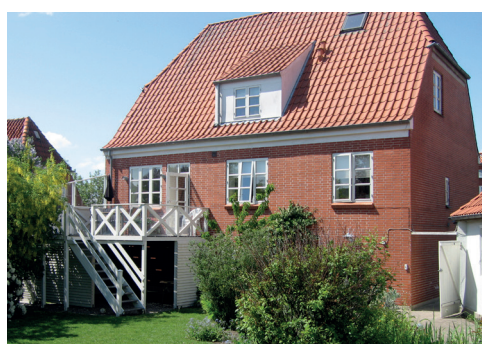
Havesiden 2009 med "høj" træterrasse.
